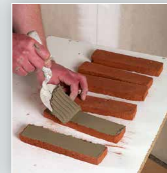
10. Achterzijde Terca baksteenstrip inlijmen
