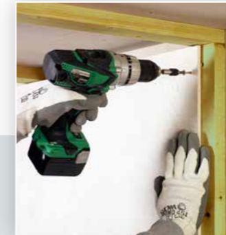
2. Monteren Eternit vezel-cementplaat
