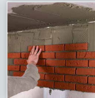
11. Aanbrengen Terca baksteenstrip
