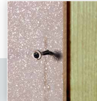
3. Gebruik schroef met bolkop (Eternit)
