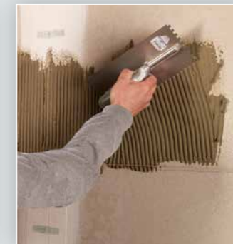
8. Aanbrengen Omnicol lijmmortel
